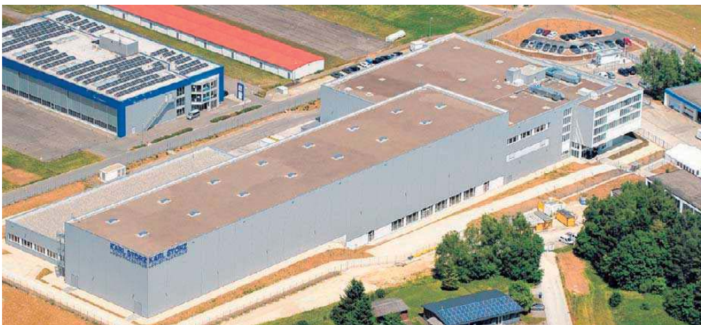
Das neue Storz-Logistikzentrum in Neuhausen ob Eck ist das größte Gebäude im Landkreis Tuttlingen. FOTO: PLESSING
